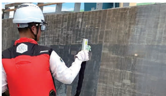
水冷式により、高出力モデルも長時間安定して作業が可能。
